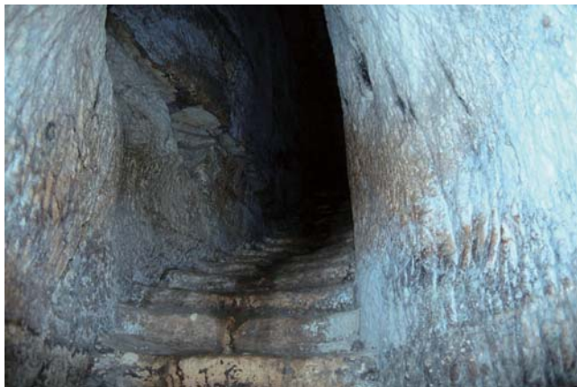
基遍水利工程的隧道
