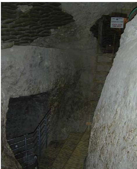
华伦竖坑入口至通往水塔的隧道
